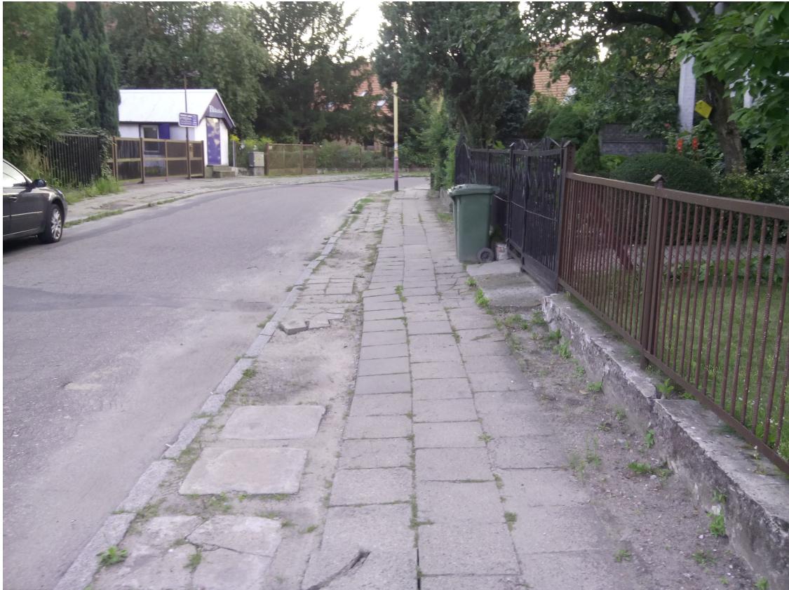
Zdjęcie 1 – Ul. Wielkopolska, strona prawa. Widok w kierunku ulicy Henryka Wieniawskiego.
