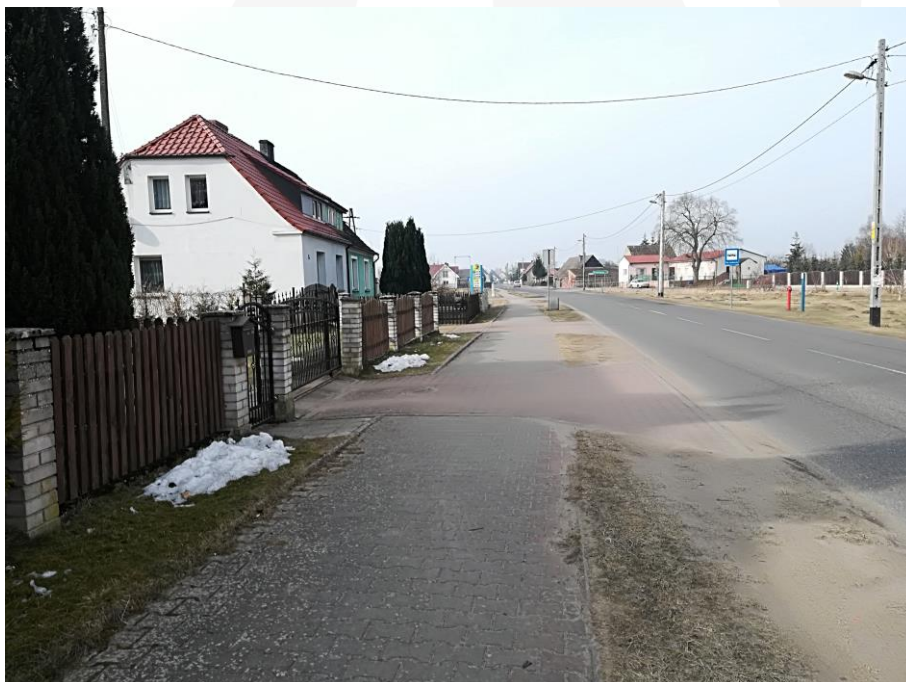
Fot. 6. Stan istniejący
