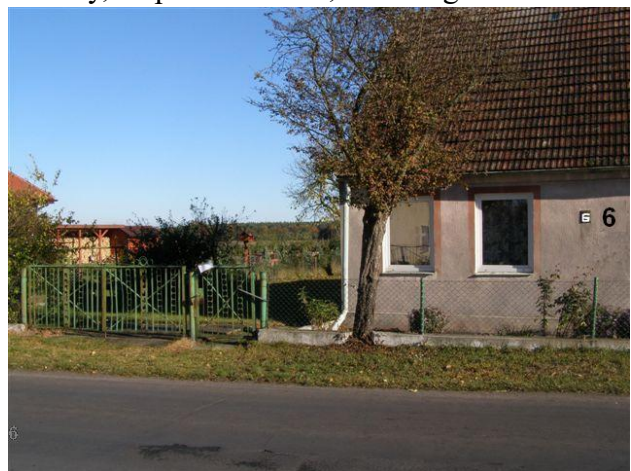
3. Działki nr 158/1 -158/2 posesja nr 22- cokół betonowy, słupki metalowe, siatka ogrodzeniowa
