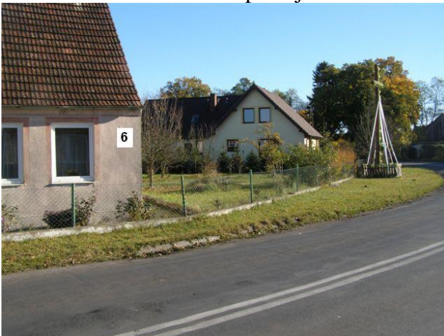
3. Działki nr 158/1 -158/2 posesja nr 22- cokół betonowy, słupki metalowe, siatka ogrodzeniowa
