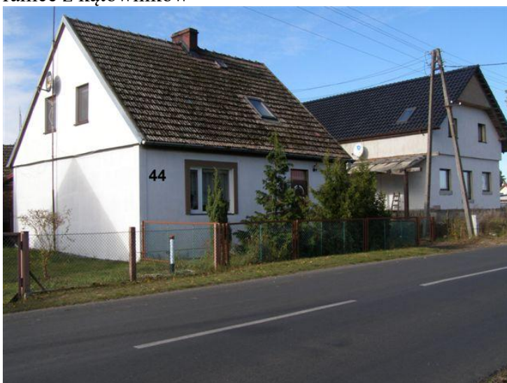
34. Działki nr 128/1 – 128/2, posesja 81 - cokół betonowy, słupki betonowe, siatka ogrodzeniowa w ramce z kątowników
