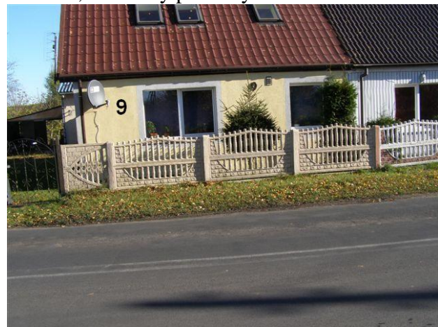
4. Działki nr 163/1 -163/2 posesja nr 34 - słupki betonowe, elementy prefabrykowane betonowe
