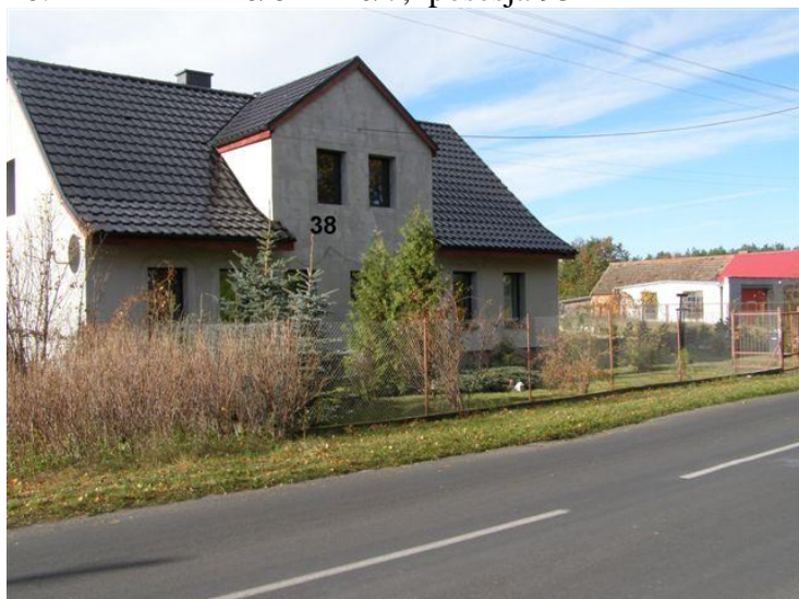
40. Działki nr 140/6 – 140/7, posesja 93 - cokół betonowy, słupki metalowe, siatka ogrodzeniowa
