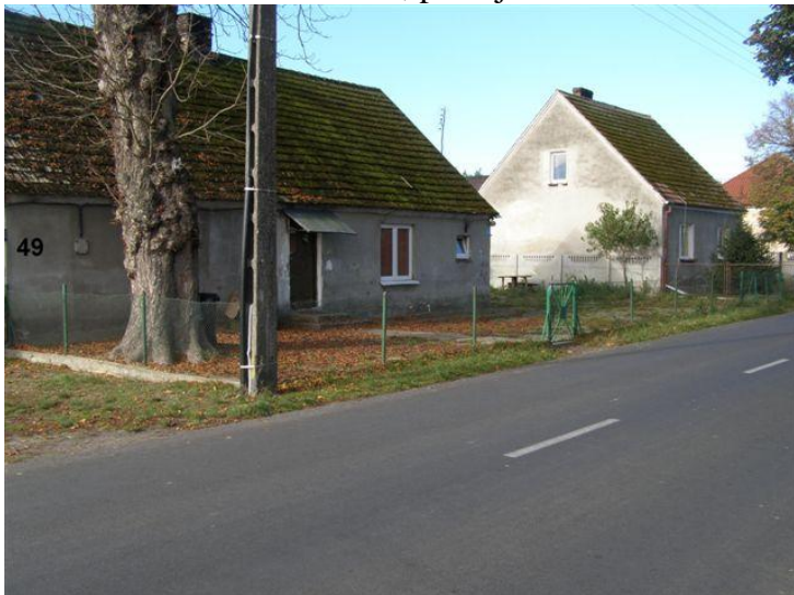
28. Działki nr 121/3 – 121/4, posesja 69 - cokół betonowy, słupki metalowe, siatka ogrodzeniowa
