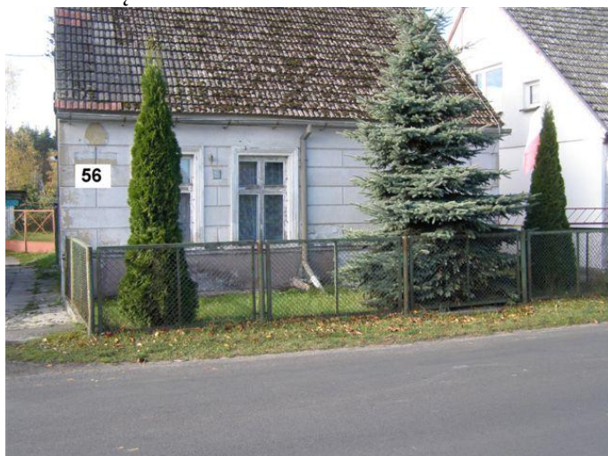
19. Działka nr 109/1 – 109/2 posesja 49 - cokół betonowy, słupki metalowe, siatka ogrodzeniowa w ramce z kątowników
