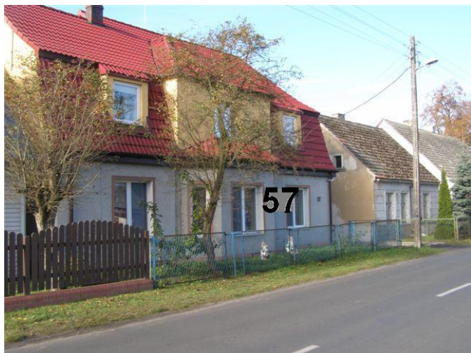
19. Działka nr 109/1 – 109/2 posesja 49 - cokół betonowy, słupki metalowe, siatka ogrodzeniowa w ramce z kątowników
