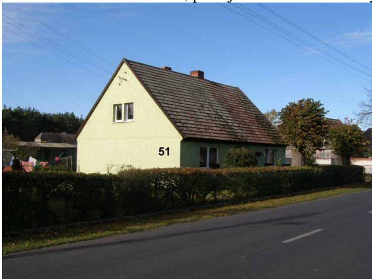
26. Działki nr 119/1 – 119/2, posesja 65 - cokół betonowy, słupki metalowe, siatka ogrodzeniowa
