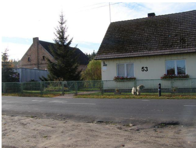
25. Działki nr 117/1 – 117/2, posesja 63 - cokół betonowy, słupki metalowe, siatka w ramce metalowej
