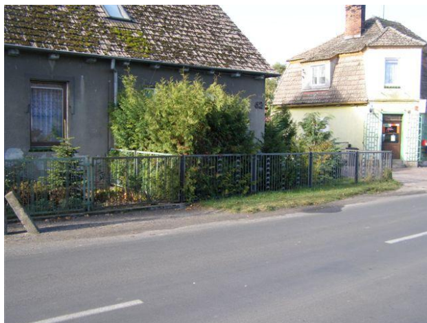
14. Działki nr 100/1 – 100/2, 101/1 – 101/2 posesja 37 - cokół betonowy, słupki metalowe, ramka ogrodzeniowa
