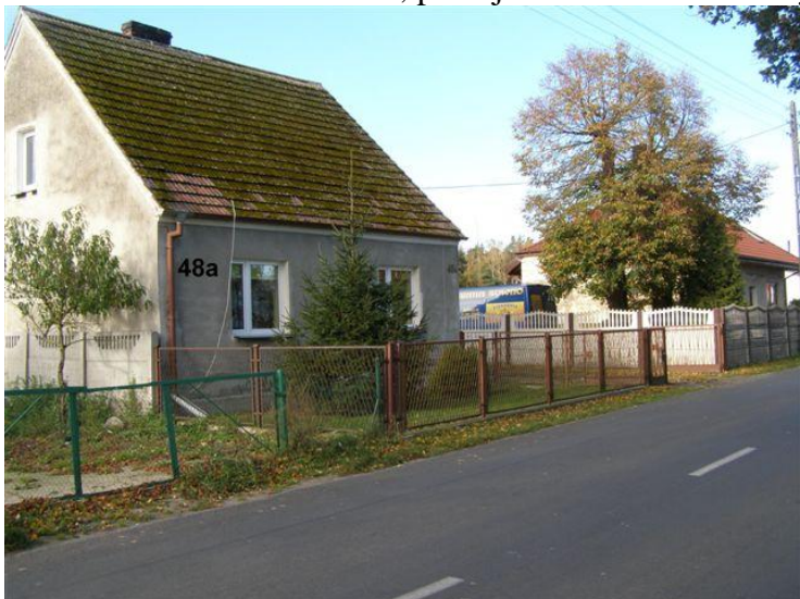
29. Działki nr 123/1 – 123/2, posesja 71 - cokół betonowy, słupki metalowe, ramka metalowa
