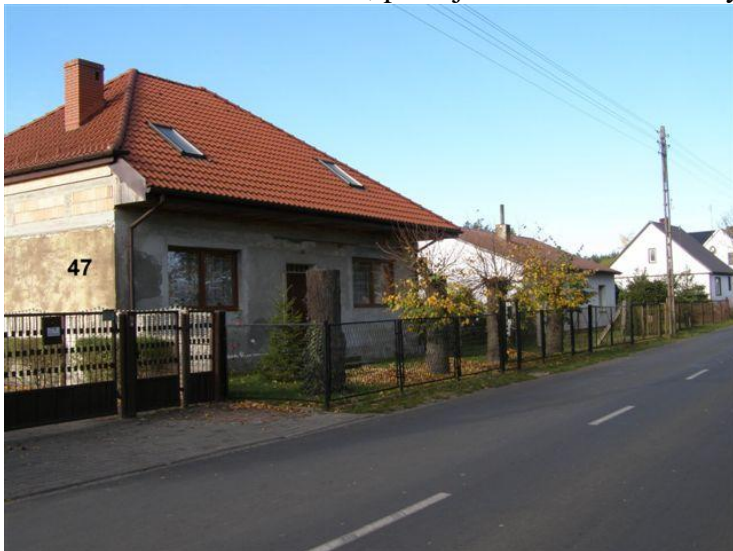
31. Działki nr 125/1 – 125/2, posesja 75- cokół betonowy, słupki metalowe, ramka metalowa
