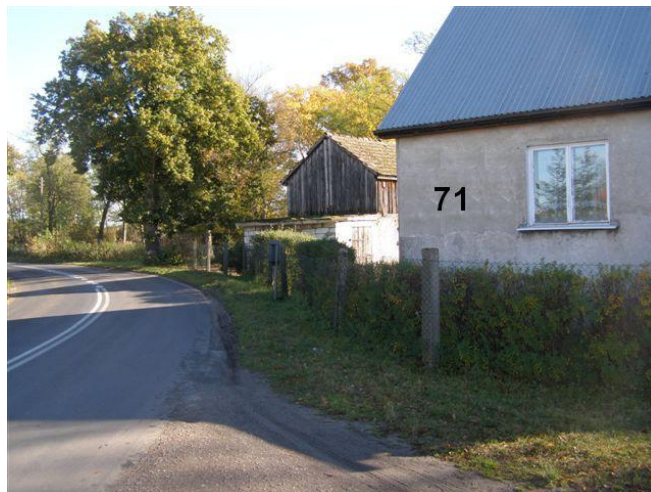
48. Działki nr 76/1 – 71/2, ul. Szkolna posesja 1 - cokół betonowy, słupki betonowe, siatka ogrodzeniowa
