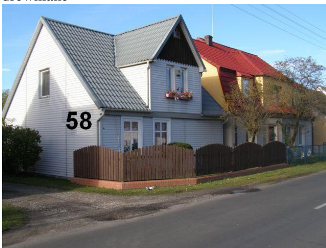
17. Działki nr 107/1 – 107/2 posesja 45 - cokół z cegły klinkierowej, słupki drewniane, wypełnienie drewniane
